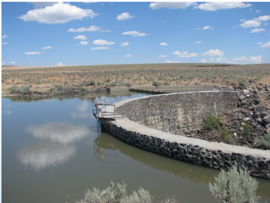
Arock Dam in Malheur Co.
